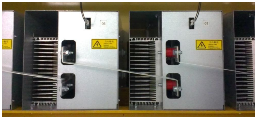
图 5-5 链式静止无功发生器功率模块
